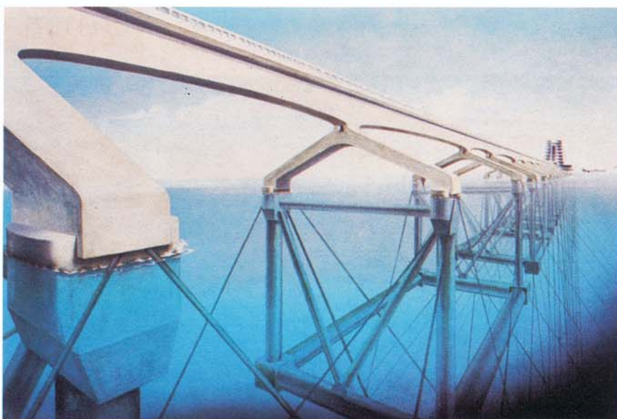
Puente sobre apoyos flotantes
